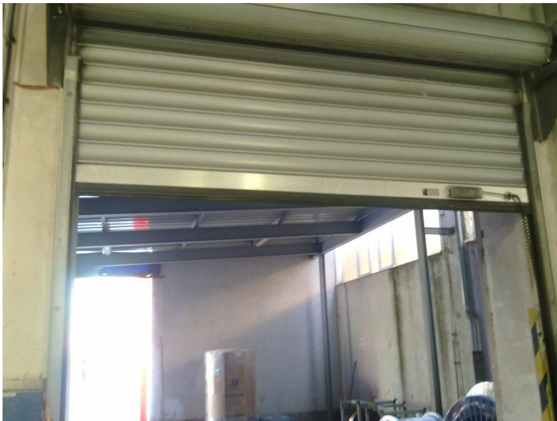
Dolní hrana roletových vrat bez černožlutého označení
