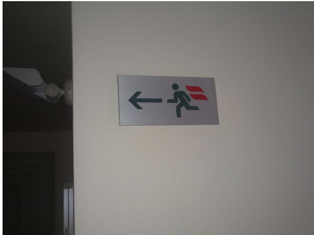
Evakuační značení neodpovídající předpisům
