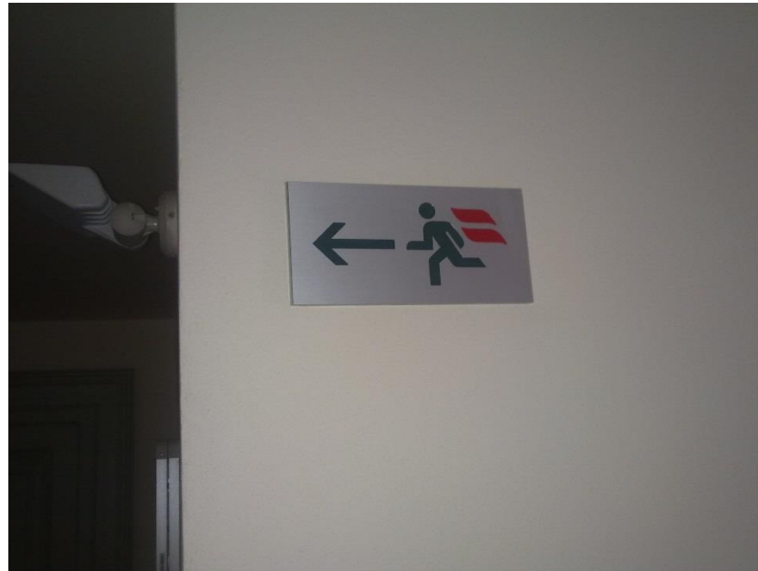
Evakuační značení neodpovídající předpisům
