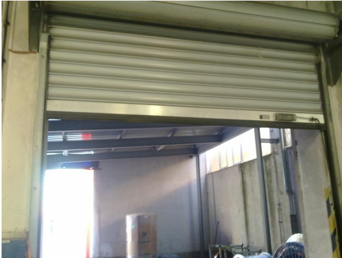
Dolní hrana roletových vrat bez černožlutého označení
