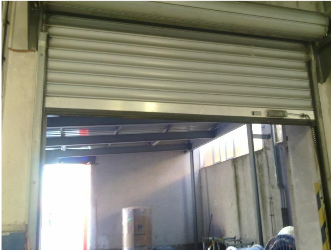
Dolní hrana roletových vrat bez černožlutého označení
