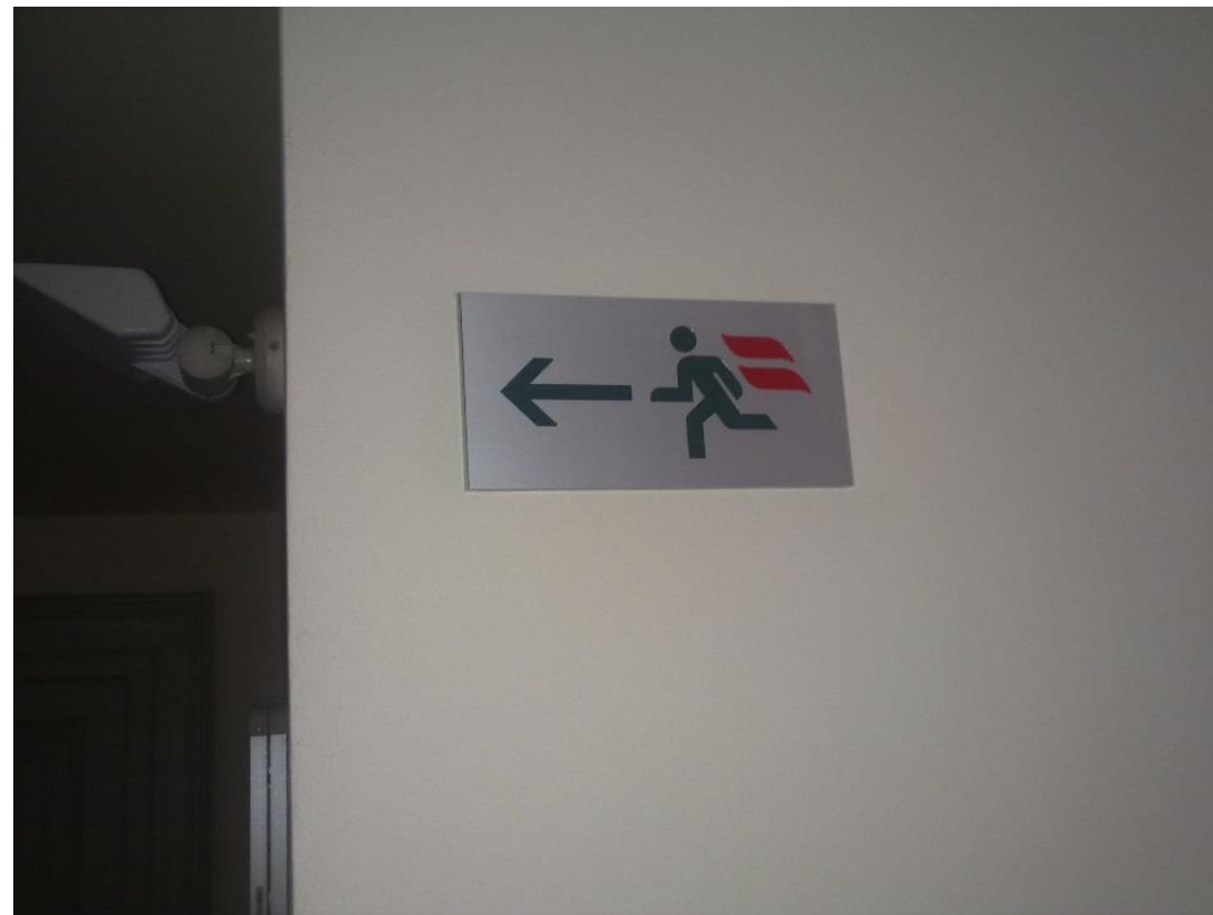
Evakuační značení neodpovídající předpisům
