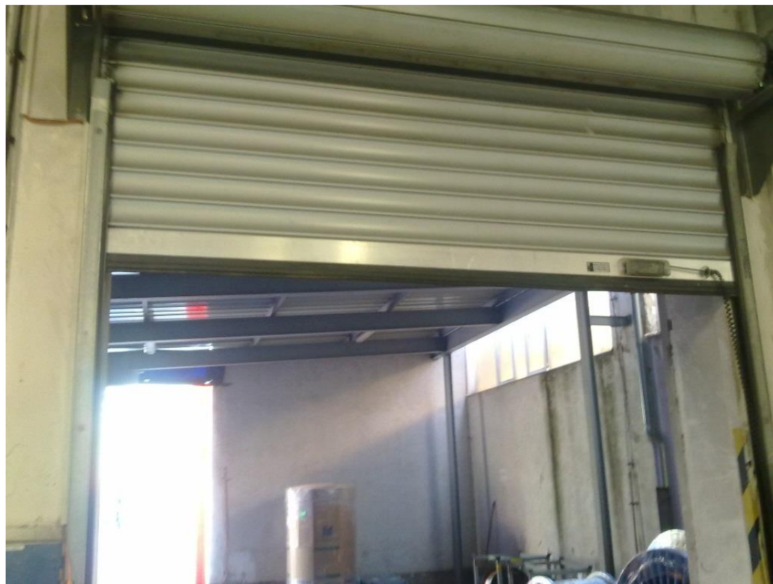
Dolní hrana roletových vrat bez černožlutého označení
